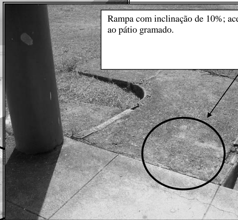
Foto 6 – Rampa de acesso ao pátio
